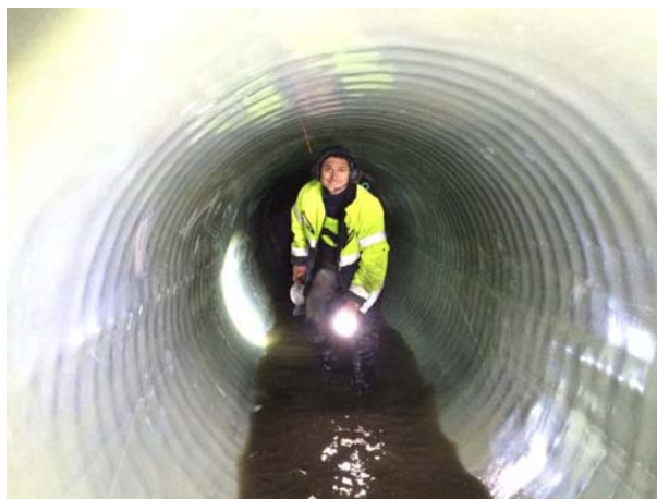
Bauleiter Magnus Eriksson (NCC) nach der Sanierung im Berolina-Liner DN 1600
