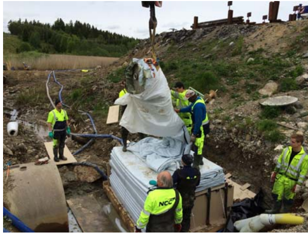
Montierter Packer wurde zusammen mit dem Schlauchliner eingezogen
