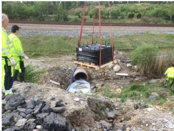
Der Berolina-Liner wird vor dem Durchlass platziert
