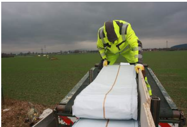
Mit Hilfe eines Förderbandes wurde der 354 m lange Liner in den zu sanierenden Mischwasserkanal eingezogen.
