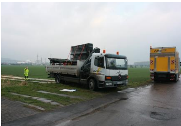
Der aufgeweichte Untergrund erschwerte die Anfahrt an den Startschacht.
