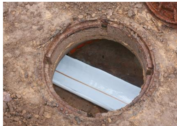
Der Berolina-Liner beim Einziehvorgang in einem der fünf Zwischenschächte
