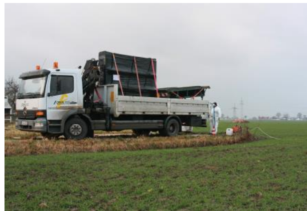
Der 354 m lange und 2,50 m hoch gestapelte Berolina-Liner wurde auf einem Pritschen-LKW zur Baustelle gefahren.
