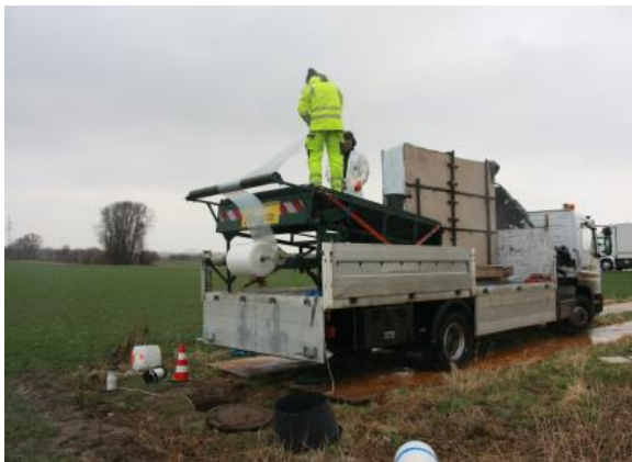
Die Schutzfolie wurde am Berolina-Liner befestigt – das „Gesamtpaket“ wurde zusammen in den 354 m langen Abwasserkanal eingezogen.
