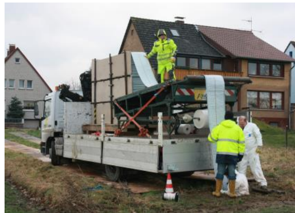
Der Einziehvorgang des 354 m langen Liners hat fast eine Stunde gedauert.
