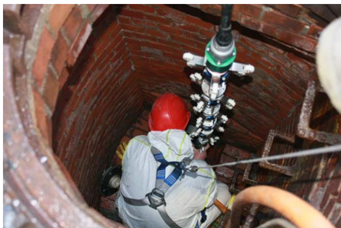
Die Lichtquelle 8x400 Watt wird in den Berolina-Liner eingeführt
