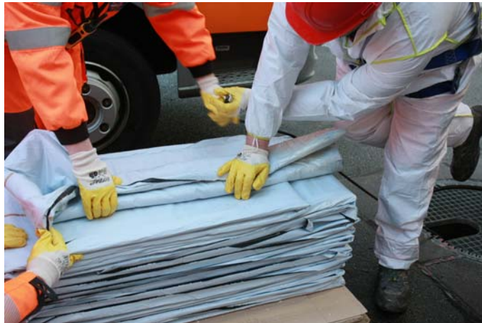
Hand in Hand wird der Zugkopf gebunden
