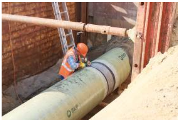
Aushärtung GFK-Umhüllung mittels UV-Licht
