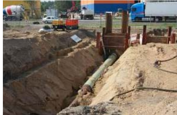
Gesamtübersicht Baugrube (Abschnitt I), Bundesstraße musste nicht gesperrt werden
