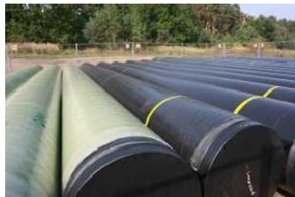
Lagerplatz Gasrohre mit (grünlich) und ohne BWB-Schutzummantelung
