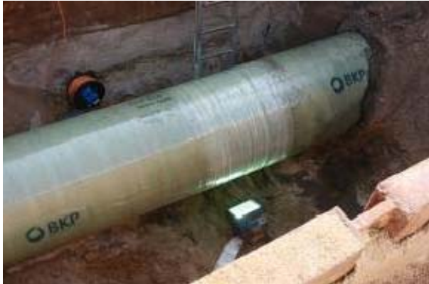
Aushärtung GFK-Umhüllung mittels UV-Licht
