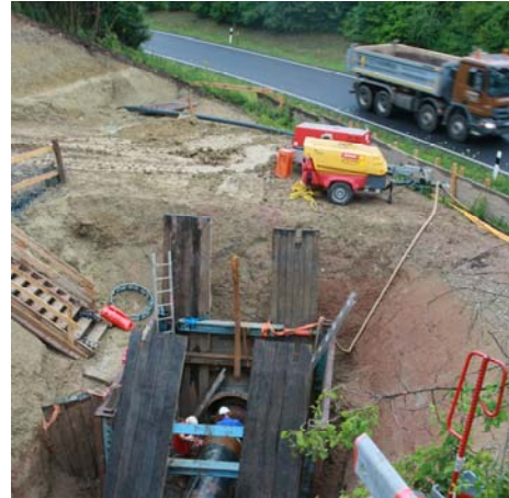
Zielgrube an der Autobahnauffahrt
