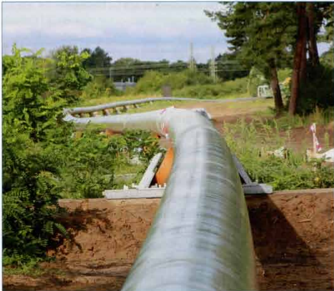
Der mit GfK ummantelte Rohrstrang.
