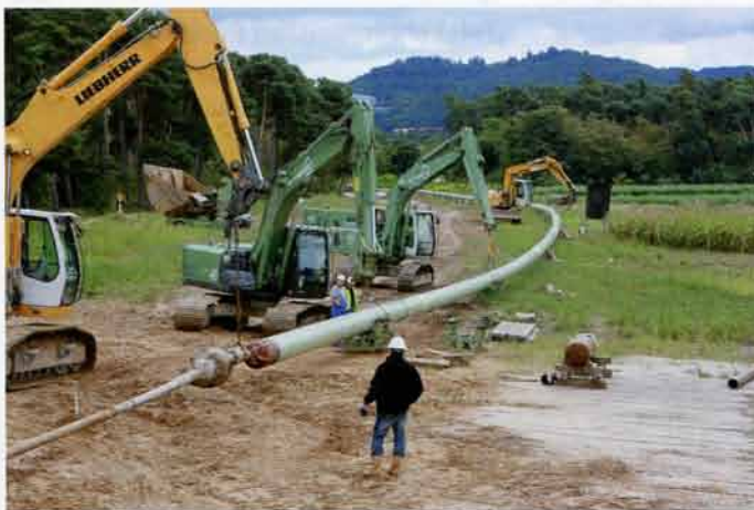
Letzte Vorbereitungen für den Rohreinzug.
