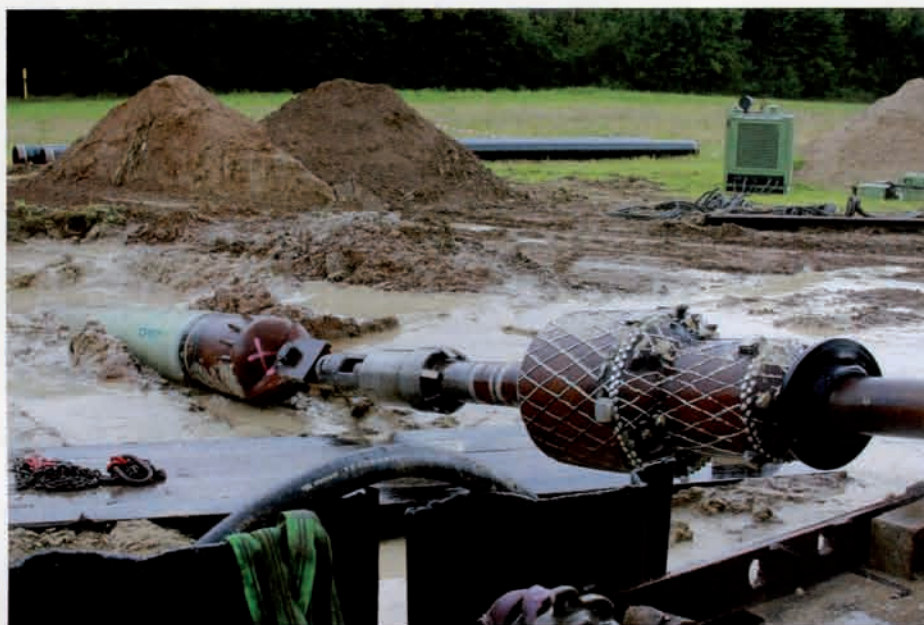
560 m GfK-ummantelter Rohrstrang DN 500
