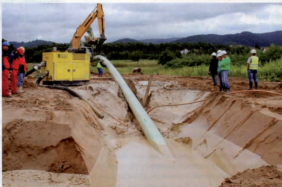
Der Rohrstrang wird eingezogen.
