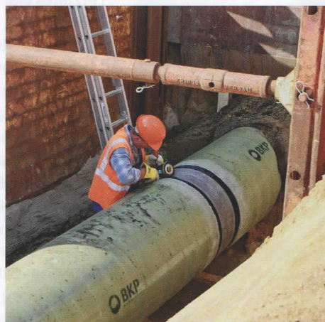
Bild 2: Nachbearbeitung des Schweißnahtbereiches
