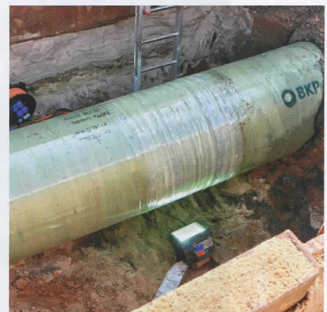
Bild 3: Aushärten des mittels Handlaminat umhüllten Schweißnahtbereiches mit UV-Licht
