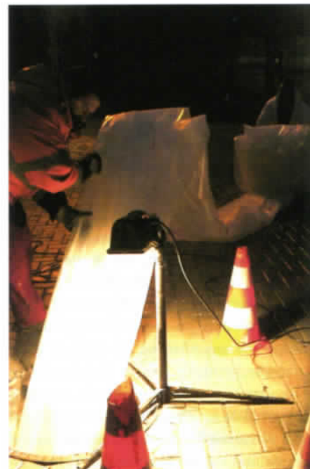
Entfernen der Innenfolie nach Aushärtung.
