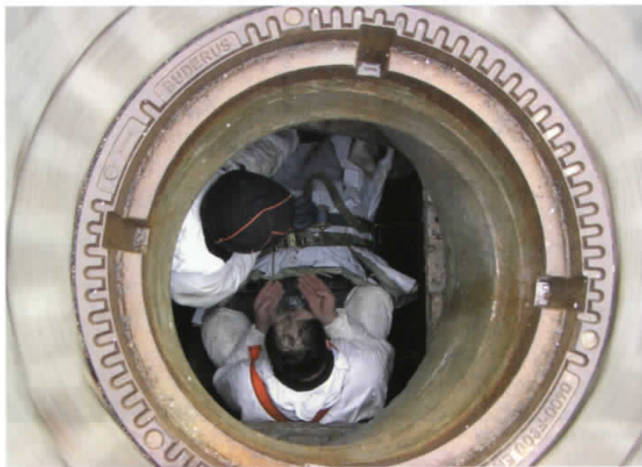
Berolina-Liner mit neuer Dimension im Untergrund
