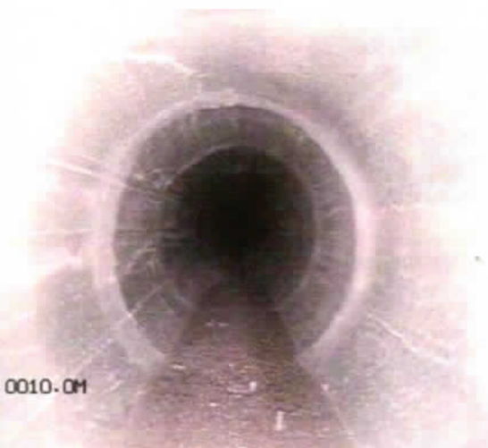
Sanierungsergebnis: Das Schmutzwasser kann wieder ungehindert fließen.
