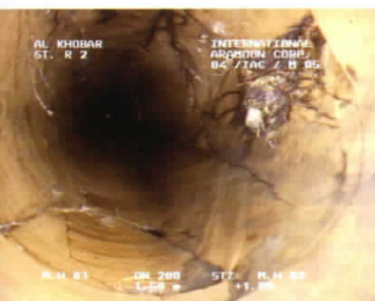
Eine Kamerabefahrung zeigte ein deutliches Schadensbild: Scherbenbildung, Infiltrationen und Wurzeleinwüchse.
