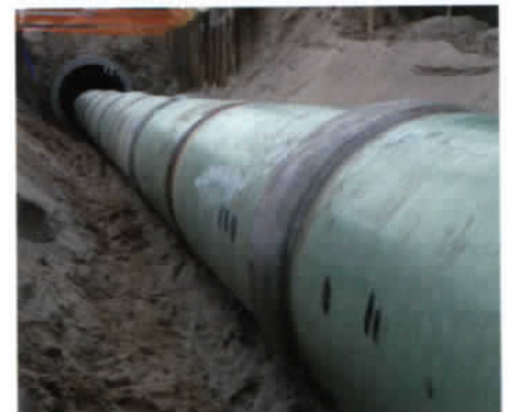
Ein Testrohr DN 1400 mit Rohrummantelung und Gleitkufen, welches ca. 350 m durch einen Rohrstrang gezogen wurde. Ein Abrieb war nicht festzustellen.
