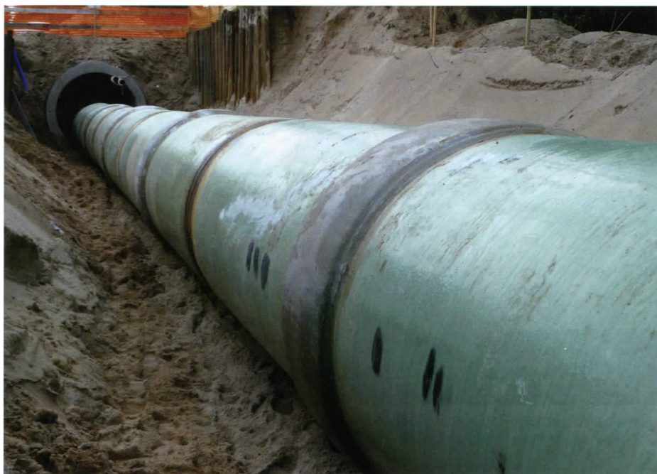
350 Meter langes Testrohr mit Gleitkufen.
