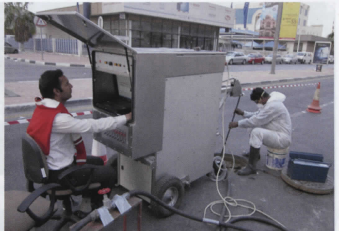
Die mobile UV-Anlage ist besonders für Arbeiten geeignet, bei denen so wenig Platz wie möglich in Anspruch genommen werden darf.
