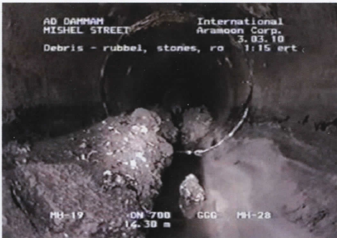
Die Kamerabefahrung vor der Sanierung zeigte die Schäden im Kanalnetz auf.
