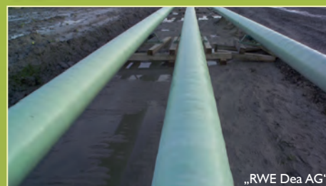
Lagerung der Rohrstränge für späteren Einzug in Horizontaltalbohrungen.
