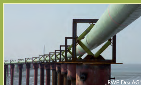
Über Pfähle mit Rollenlagern wurden die Leitungen zu den Baugruben gezogen.
